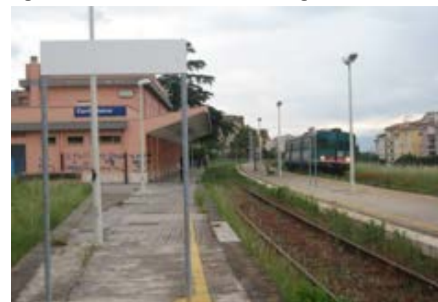
Figura 89 - Stazione Ferroviaria di Corigliano
