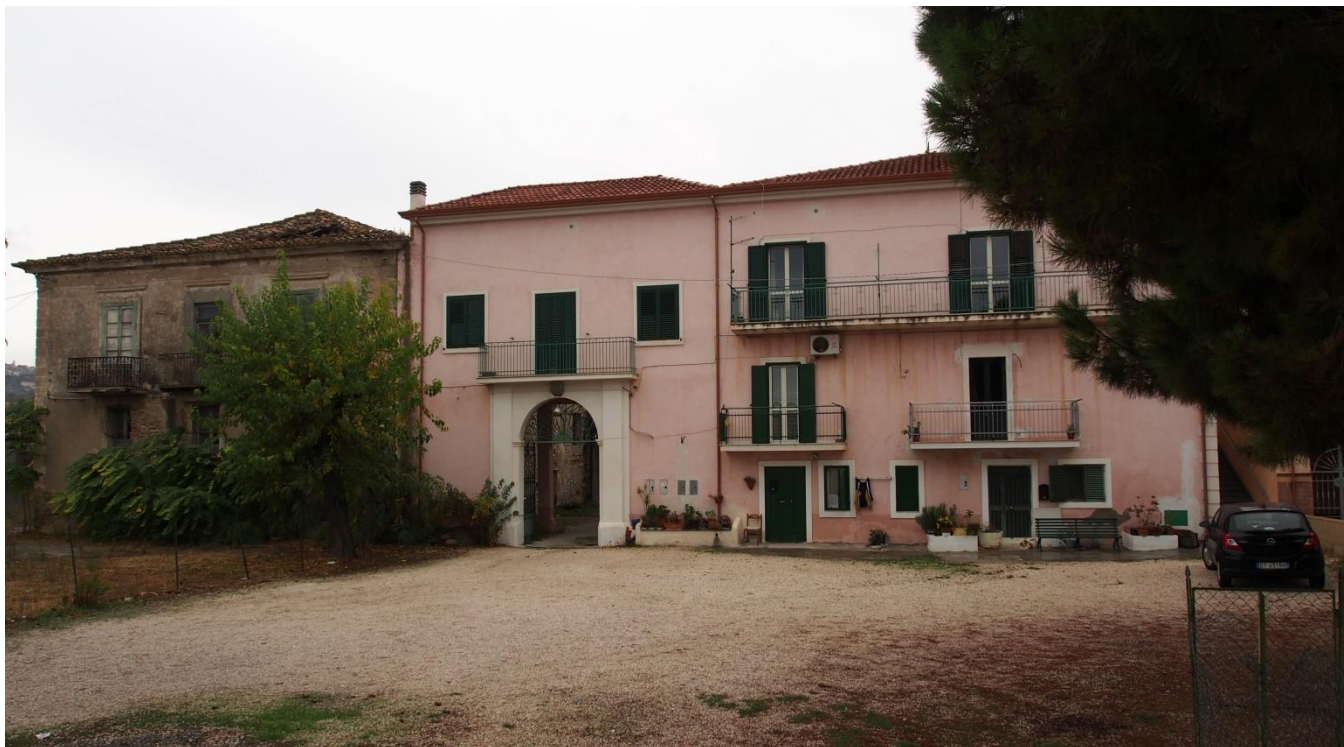
Figura 46 – Borgo S. Giacomo, edifici che si affacciano sul lato est del borgo.
