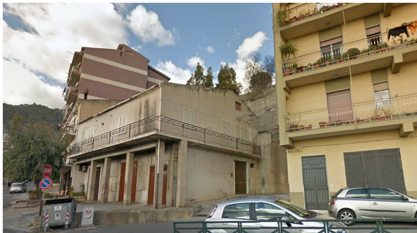
Figura 7 – Comune di Cassano allo Ionio, vista da via Vittorio Emanuele di alcuni degli edifici esclusi dal perimetro del centro storico definito dal PSA. La zona
